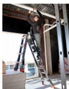
Montagem em desnível. Secções extensíveis em alturas distintas
